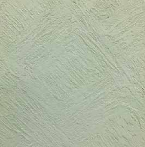
ノワ スポンジゴテをクロス柄に引き、金ゴテで押さえた仕上げ。 仕上厚：3mm
