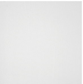
ローマン (小面積) 金ゴテでフラットに押さえた仕上げ。
