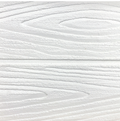
擬木 木の板をイメージして、木目をコテで造形した仕上げ。
