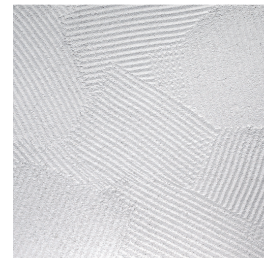
楕引コテムラ 楕引のコテを使って作るコテムラ仕上げ。
