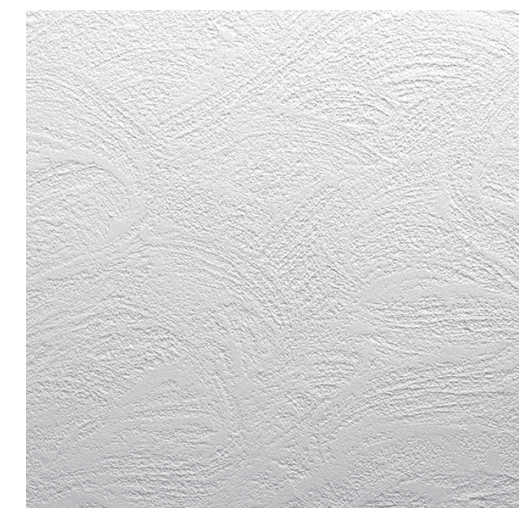
うず 木ゴテを回しながら模様を付け金ゴテで押さえた仕上げ。
